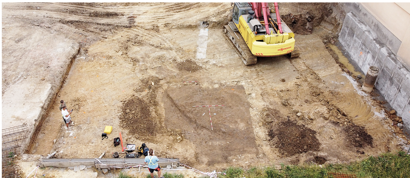
Obr. 32. Kroměříž. Pohled na začistěný suterén novověkého domu. Foto M. Popelka.
