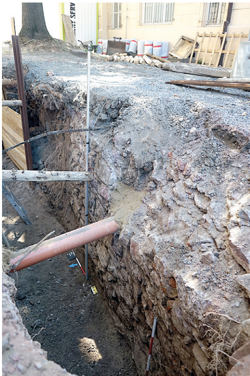
Obr. 24. Brno, Fakultní nemocnice u sv. Anny. Vyzdění severního břehu Svrateckého náhonu v sondě S4. Foto Archaia Brno z. ú.
