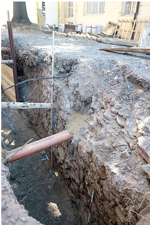
Obr. 24. Brno, Fakultní nemocnice u sv. Anny. Vyzdění severního břehu Svrateckého náhonu v sondě S4. Foto Archaia Brno z. ú.
