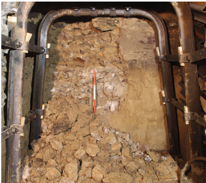
Obr. 12. Brno, ulice Besední. Vyzdění kontreskarpy příkopu v ražbě. Foto Archaia Brno z. ú.
