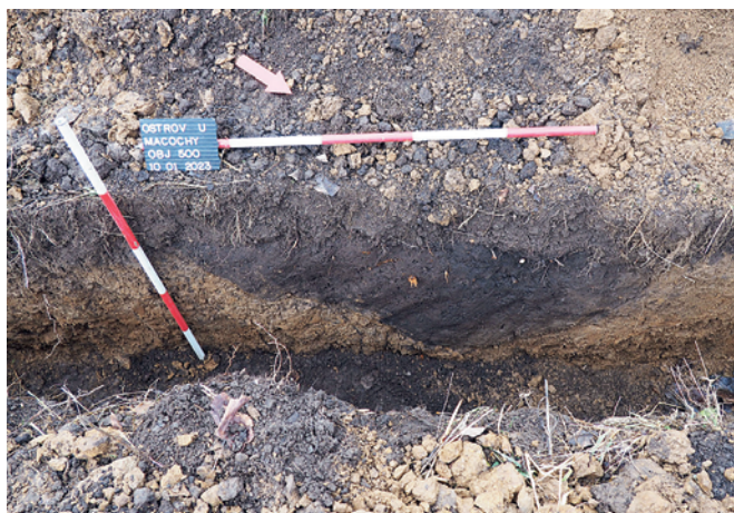
Obr. 16. Ostrov u Macochy. Jihozápadní profil objektu 500. Foto M. Novák.
