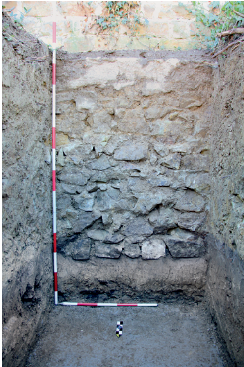
Obr. 68. Uherský Brod, ulice Horní Valy. Základy hradební zdi zachycené v jedné ze sond. Foto Z. Kuchař.
