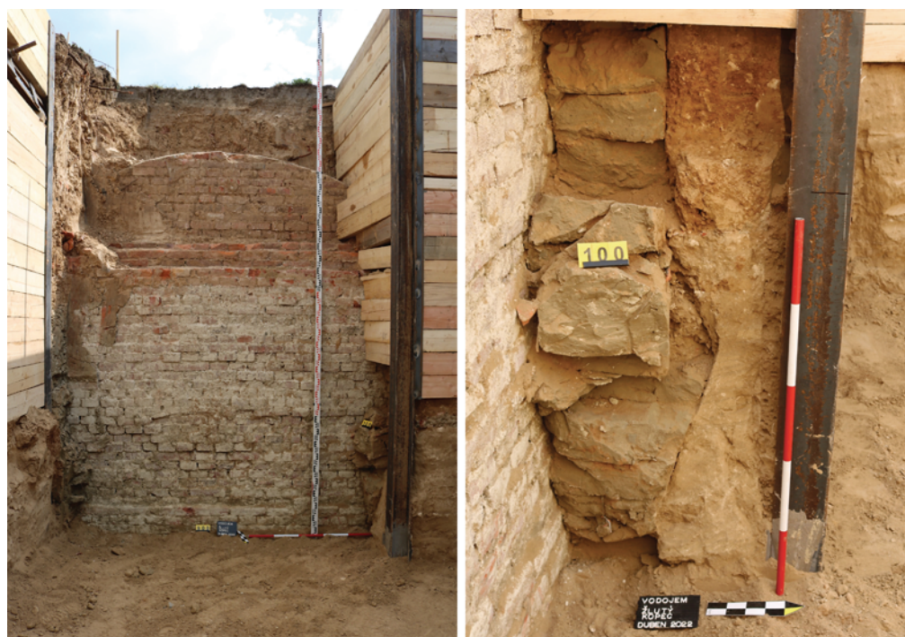
Obr. 26. Brno, ulice Tvrdého. Sonda S1 s odkrytými historickými konstrukcemi vodojemu z roku 1894. Zajílování pomocí jílových lisovaných kostek s. j. 100. Foto Archaia Brno z. ú.
