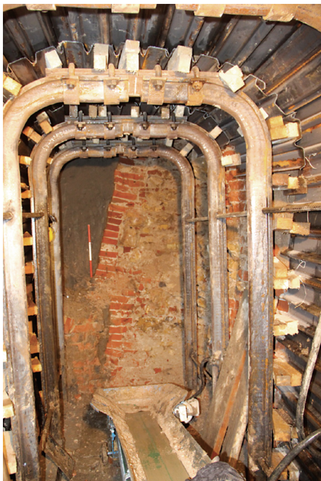
Obr. 7. Brno, Komenského náměstí. Na čelbě ražby je patrné vyzdění kontreskarpy novověkého příkopu. Foto Archaia Brno z. ú.
