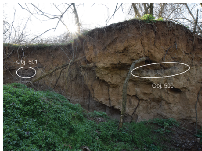
Obr. 3. Pohled na část propadu sklepa se zbytky objektů na profilu. Foto D. Rožnovský.
