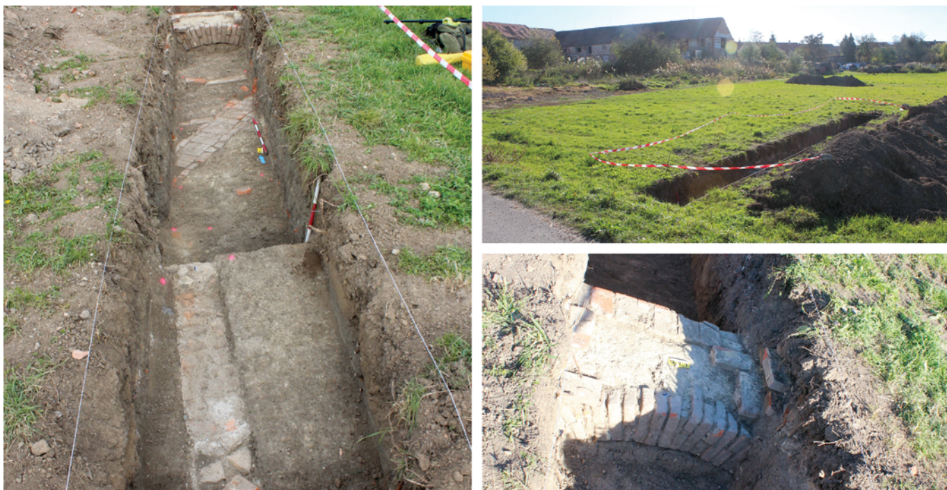
Obr. 78. Pouzdřany. Sonda S6 západně od zámku na zahradě s konstrukcemi kanálku a patrně obvodové zdi zahrady. Foto Archaia Brno z. ú.
