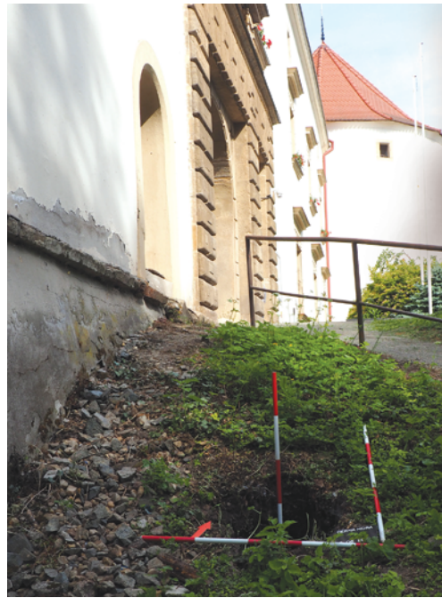
Obr. 42. Černá Hora. Pohled na propadený vchod do podzemních prostor v předpolí vstupního křídla předzámčí. Foto M. Novák.
