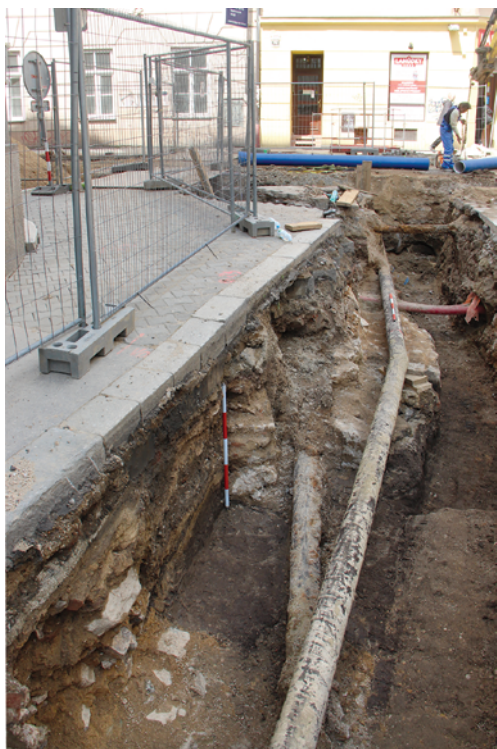
Obr. 9. Brno, ulice Solniční. Pohled od jihu na výkop při křižovatce s ulicemi Česká a Veselá. V popředí relikty staré zástavby, v pozadí středověká hradba. Foto Archaia Brno z. ú.
