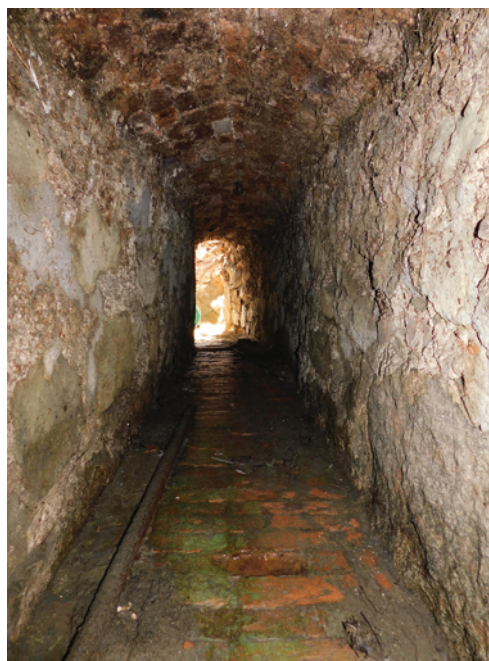
Obr. 3. Blansko, Zámek 3. Průhled novověkou kanalizační stokou směrem od hlavní budovy zámku k objektu Zámek 3. Foto J. Štětina.
