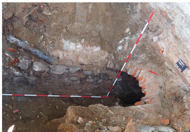
Obr. 2. Blansko, Zámek 3. Kanalizační stoka s narušenou cihlovou klenbou v místě, kde zabíhá pod budovu Zámek 3. Foto M. Novák.
