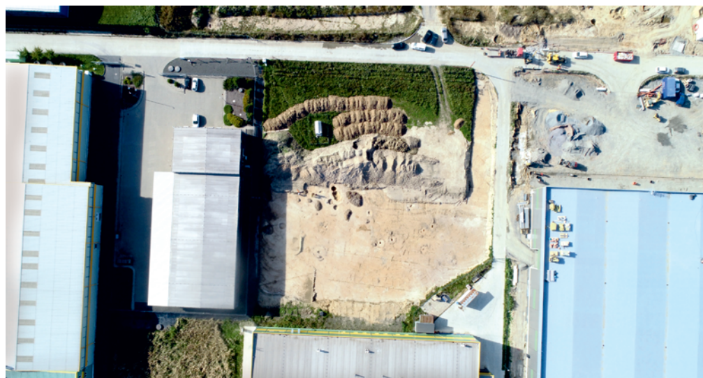
Obr. 15. Otice. Pohled na výzkum v rámci výstavby tří hal firmy JATKA-KURKA s. r. o. z ptačí perspektivy (snímek pořízen pozemním vrtulníkem DJI PHANTOM 4 PRO+). Foto J. Juchelka.
