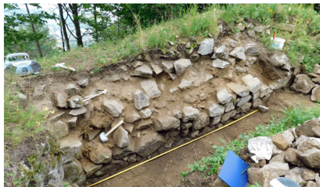
Obr. 84. Podhradní Lhota, Nový Šaumberk. Pohled od jihu na vnitřní líc hlavní hrabdy – stav před konzervací. Foto R. Vrla.
