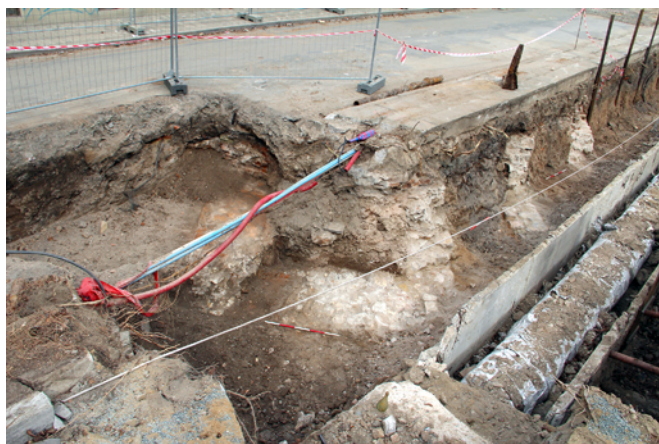
Obr. 50. Brno, ulice Lazaretní a Stará osada. Relikty zděných konstrukcí historické stavby v mírném ohybu Lazaretní ulice v úseku mezi Vojenskou nemocnicí a Zbrojovkou. Pohled od jihozápadu. Foto Archaia Brno z. ú.
