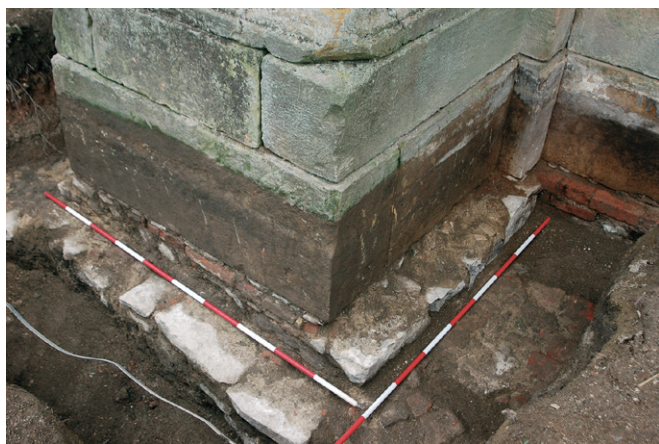
Obr. 74. Plumlov (okr. Prostějov), nádvoří zámku. Struktura základového zdiva pilíře při vnitřní obvodové stěně objektu. Foto P. Fojtík.
