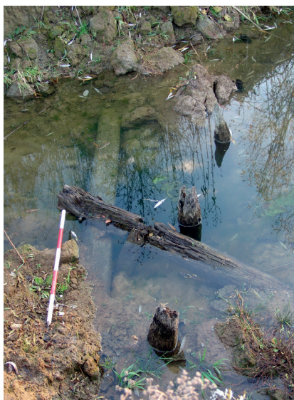
Obr. 17. Mohelnice „Za Moravou“ 2006. Pokračování dřevěného mostu nebo lávky (2. polovina 16. století) s řadou nosných kůlů a detailem spojení (konstrukce 1). Foto V. Vránová.
