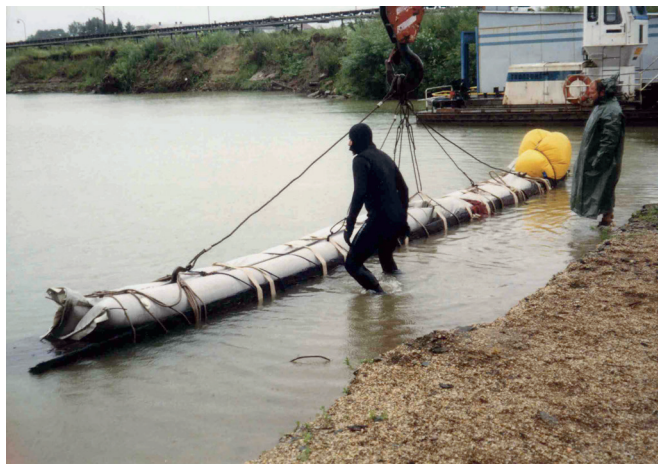
Obr. 7. Mohelnice „U Moravy“ 1999. Transport lodí na druhý břeh šterkovny pomocí norných stěn a vyzvednut autojeřábem. Foto archiv ACO.
