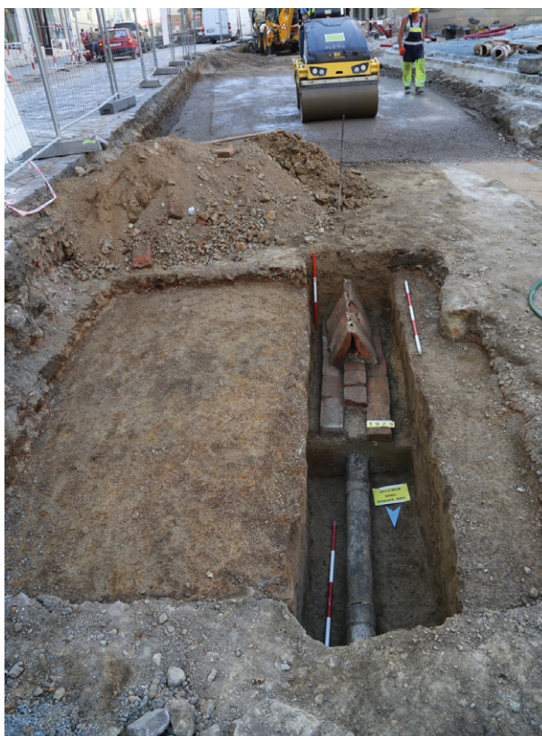
Obr. 9. Brno, Dominikánské náměstí, Panenská ulice, Veselá ulice (A13/2018). Část novověkého vodovodu z keramických trubek ve východní části náměstí. Pohled od severu.
