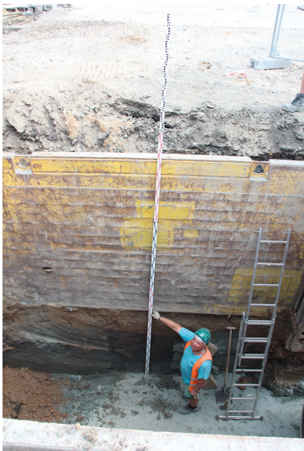
Obr. 21. Brno, Plotní ulice a okolí (A018/2018). Základové zdivo domu na ulici Dornych č. p. 46–56 po skrývce pláňe pro novou komunikaci.
