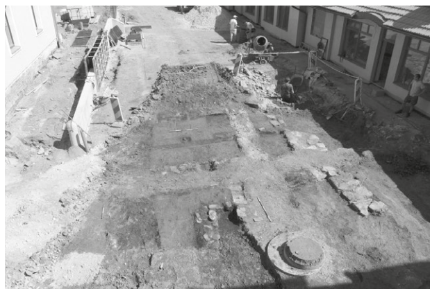
Obr. 83. Velká Bíteš. Pohled na jižní část prostoru dvora za budovou Staré pošty.
