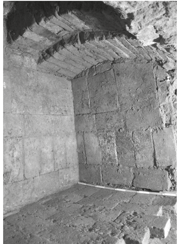
Obr. 79. Telč, Náměstí Zachariáše z Hradce 48. Snímek skladu hrnčířské hlíny obložený keramickými deskami. Archiv Archaia Brno, z. ú.
