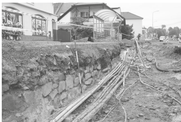
Obr. 53. Jedovnice, ulice Palackého. Část zdiva bývalého Panského domu.
