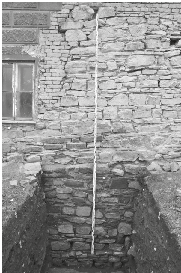
Obr. 5. Bílovec, Pivovarská ulice, dům č. p. 121. Východní fasáda po částečném odstranění omítkových vrstev, sonda S1. Detail podpovrchové a nadzemní partie vnějšího líce hradební zdi v rámci severního traktu domu. Foto F. Kolář.
