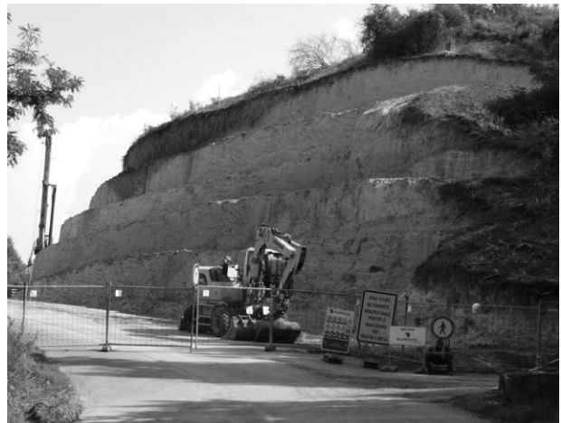
Obr. 3. Dolní Věstonice III, stabilizace svahu po se-suvech. Sprašový profil s polohami fluvialních písčitéch štěrků (mimo obr.), půd a půdních sedimentů, místy přerušovaných poklesy, a tmavou výplní zahloubené rokliny. Foto J. Svoboda.
