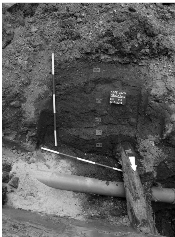
Obr. 68. Uničov, Litovelská ulice, před č. p. 192. Příčný profil dokumentující nárůst uličních vrstev a konstrukci komunikace (profil P4; foto J. Grégr).
