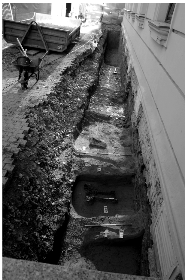
Obr. 21. Antonínská 1 (A063/2015). Pohled na část hrobových jam narušených výstavbou.
