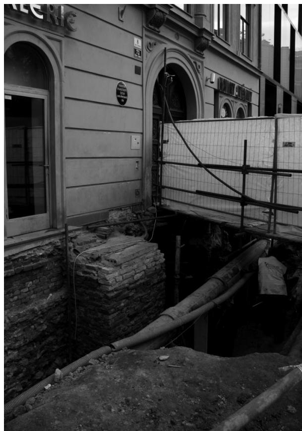
Obr. 8. Náměstí svobody 8 (A069/2015). Pohled na odkrytá zdiva sklepů domu z rubové strany.
