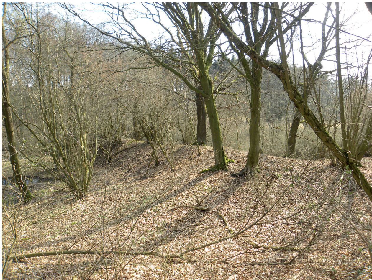
Obr. 23. Hory Vrbické u Leštiny. Vzdušná strana hráze zaniklého rybníku Vondráček s levým bočním přepadem (splavnicí) v popředí (pohled od severu). Foto J. Doležel, březen 2016.
