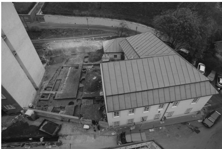
Obr. 23. Kopečná 40/ Studánka 3 (A037/2013). Pohled od západu na zkoumanou plochu.
