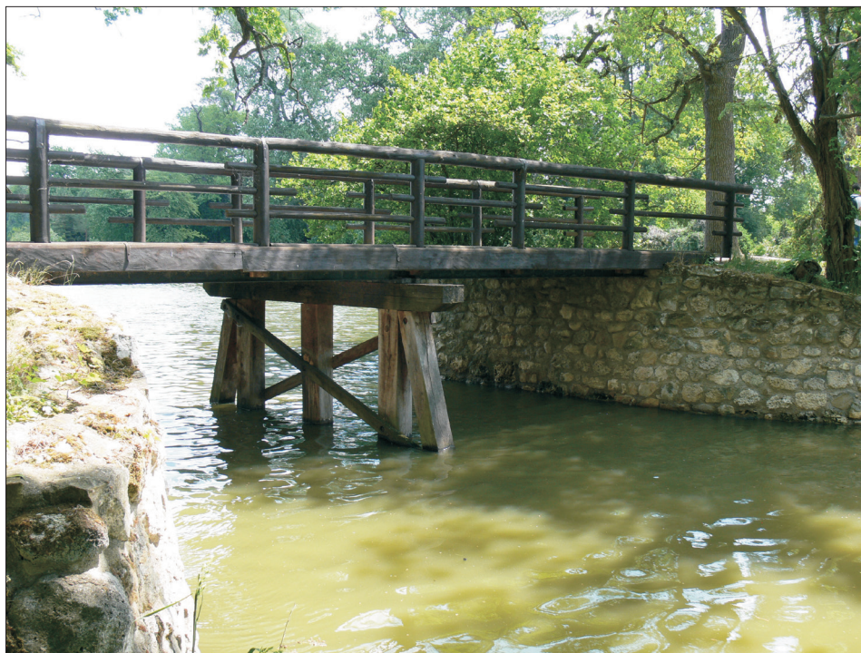
Abb. 19. Lednice, Schlosspark (Tschechien). Holzbrücke in traditioneller Bauweise. Foto G. Wilke.
