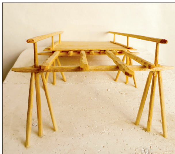
Abb. 20. Ostrów Lednicki (Großpolen). Modell der „Gnesener Brücke“ nahe am Ufer (Brückenkopf). Auch hier sind linkes und rechtes Pfahlbündel eines Jochs mit durchlochten Balken verbunden, der Verbindung nach vorn und hinten dienen lediglich Träger mit Kehlungen (nach Kola, Kuczyński, Radka, Szulta, Wilke 2010b).
