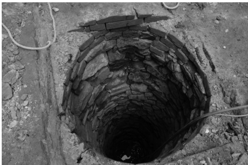
Obr. 126. Uherské Hradiště, Prostřední ulice. Pohled na odkrytou studnu ve dvoře traktu č. p. 41. Foto L. Chvalkovský.
