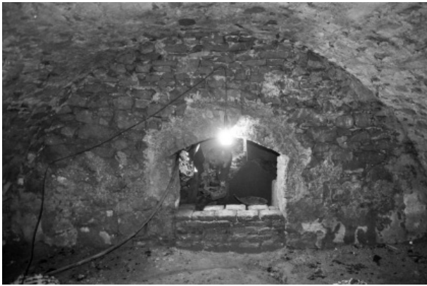
Obr. 53. Ivančice. Sklep na ulici Široká č. p. 7. Foto P. Kos.
