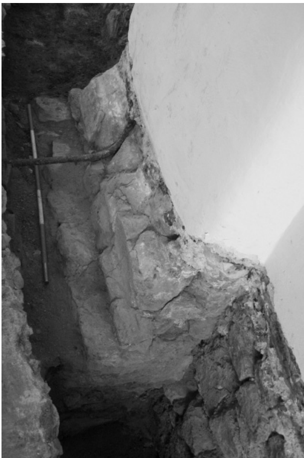
Obr. 17. Radnická 8 (A03/2012). Základy radničního jádra v průjezdu (pod věží).
