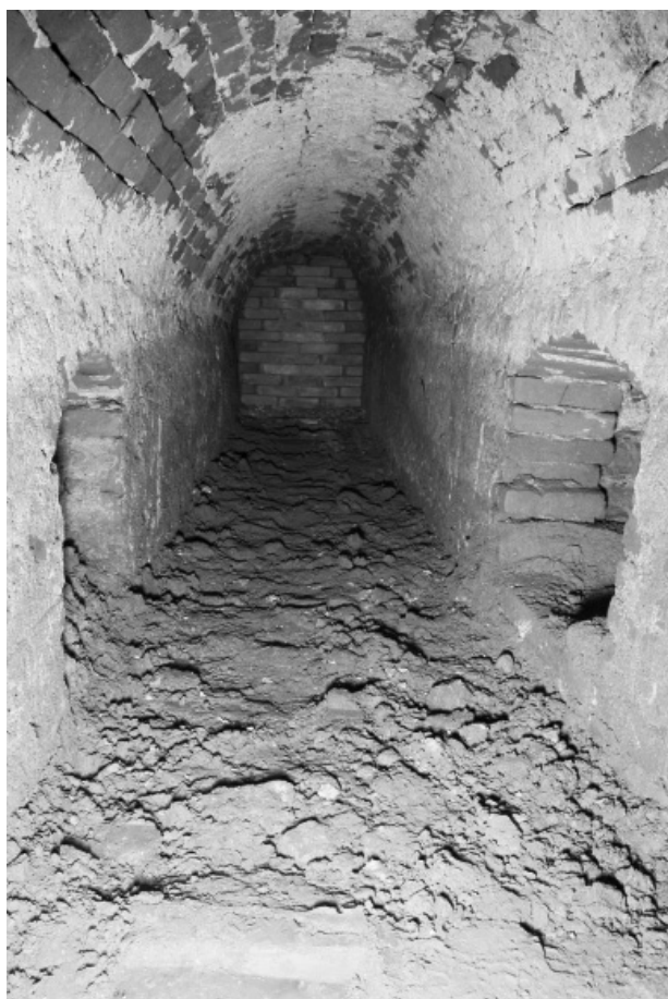
Obr. 4. Benešova, Divadelní (A099/2012). Část kasematy IV. bastionu s dvěma protilehlými nikami.
