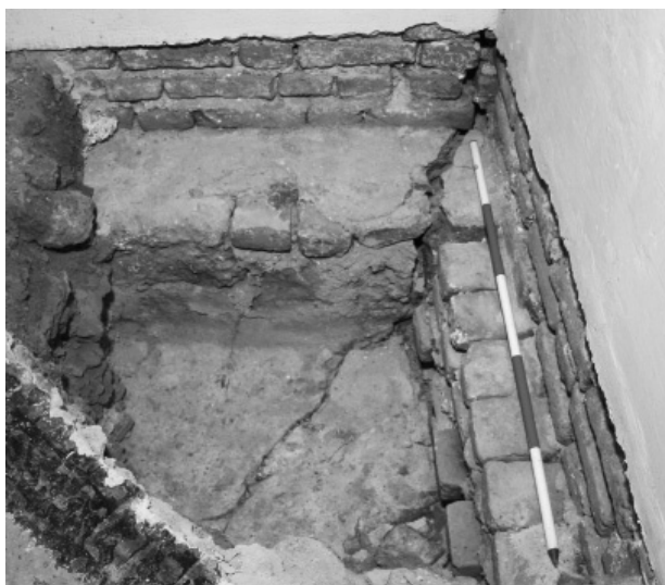
Obr. 18. Radnická 8 (A03/2012). Odkrytý rub klenby tzv. klenotnice.
