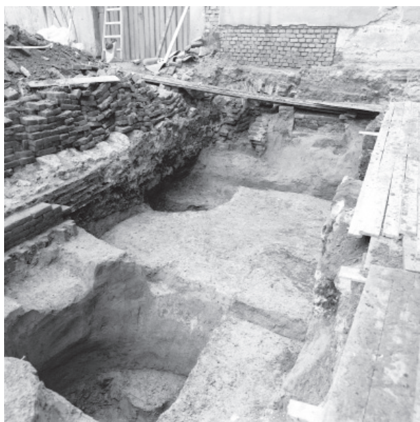
Obr. 55. Brno, Kobližná 3. 1. Pohled ze SV na suterén č. 505 s patrnými základovými žlábkami; v popředí jáma č. 509, vzadu jáma č. 511. 2. Pohled z JV na suterén č. 505, v popředí vpravo jáma č. 509.
