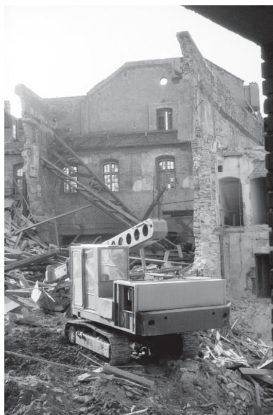
Obr. 4. Brno, Dominikánská 15. Demolice objektu někdejšího pivovaru roku 1984 po částečném zřícení zdiv. Fig. 4. Dominikánská street 15. Demolition of former brewery in 1984.
