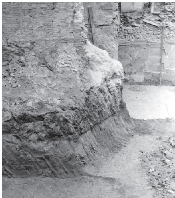
Obr. 16. Brno, Dominikánská 15, suterén č. 8, pohled z J na řezy P15, 16 (G – H – J).
