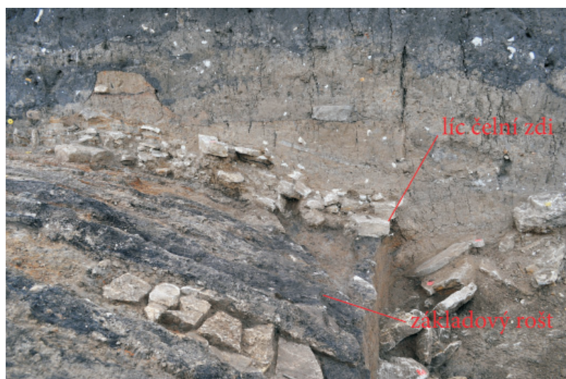
Obr. 7. Detail líce čelní kamenné zdi (v profilu), nasedající přímo na základový dřevěný rošt (lze rozpoznat křížení předních podélných desek a příčně uloženého roštu).
