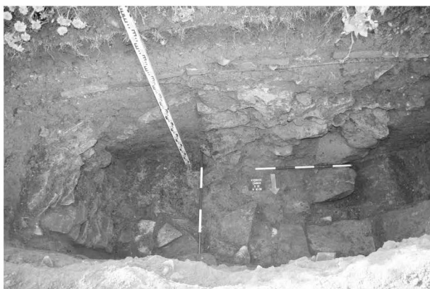
Obr. 142: Vizovice. Zámek. Pohled na středověkou stavební konstrukci. Abb. 142: Vizovice. Schloss. Der Blick auf die mittelalterliche Mauerkonstruktion.
