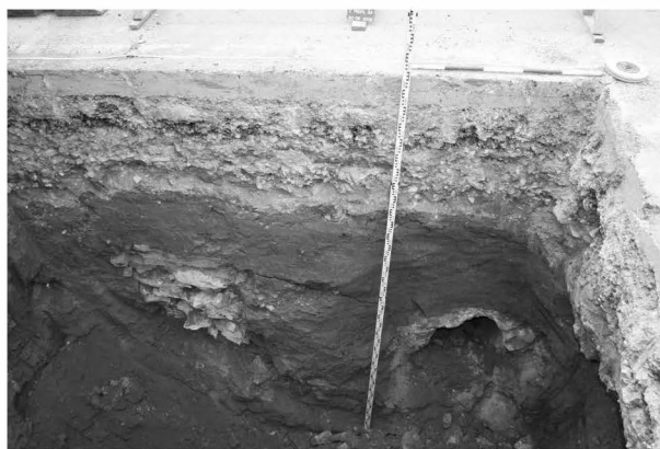
Obr. 106: Olomouc. Dolní Novosadská. Šachta Š3 – západní profil s relikty pevnostního kanálu a betonovou chodbou. Abb. 106: Olomouc. Dolní Novosadská. Schacht Š3 – westliches Profil mit Relikten des Wasserkanals und Betonkorridors.
