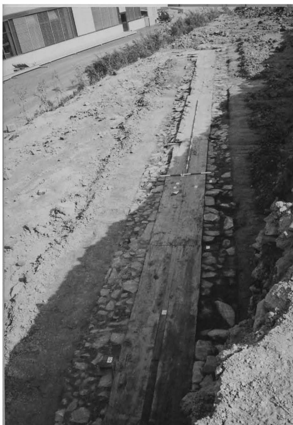
Obr. 83: Krnov-Červený dvůr. Torzo koryta vodoteče. Abb. 83: Krnov-Červený dvůr. Der Torso des Gewässerbetts.
