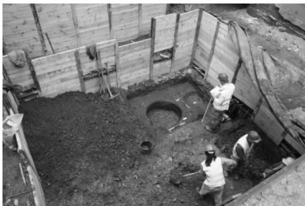
Obr. 34. Pekařská ulice č. 53 (A020/2011). Pohled na průběh exkavace od jihu.
