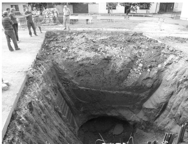
Obr. 7. Milovice IV, celkový pohled na lokalitu během rekonstrukčních prací.
