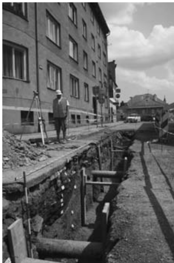
Obr. 43. Bruntál, ulice Požárníků. Profil P2 s raně novověkými zahloubenými objekty.
