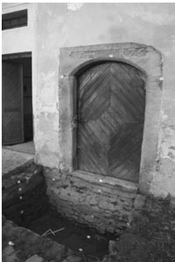
Obr. 10. Brantice. Druhotně osazený původní tufitový portál s iniciálami stavebníka (Hieronimus Reinwald) a letopočtem 1576 (foto F. Kolář).
