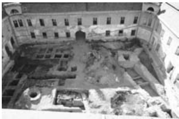
Obr. 124. Veselí nad Moravou, Zámecká ulice. Nádvoří, pohled od východu.
