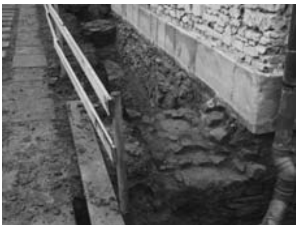
Obr. 127. Zlín-Štípa. Kamenné základy nedostavěného klášterního komplexu.
