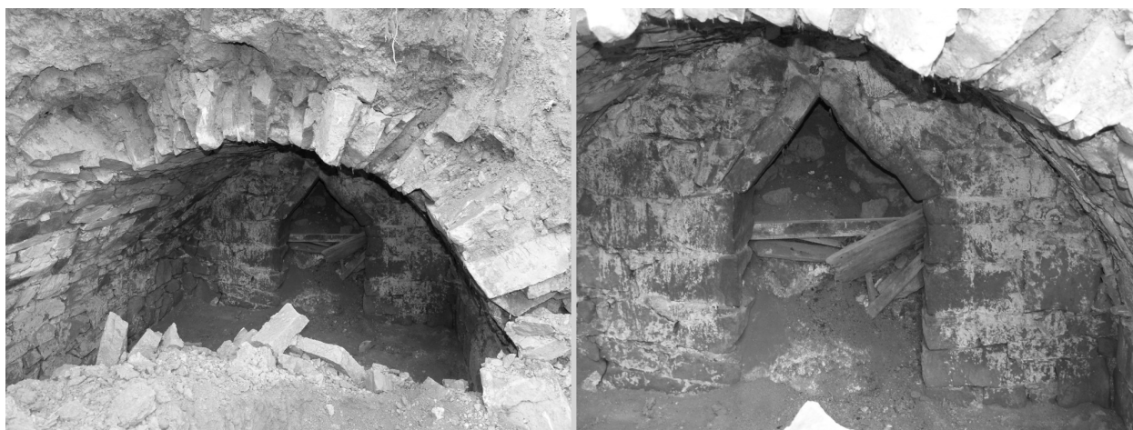
Obr. 131. Určice. Potencionální vstup do určického „podzemí“ z jednoho ze sklepů. Abb. 131. Určice. Der potentielle Eingang in den „Untergrund“ von Určice aus einem der Keller.
