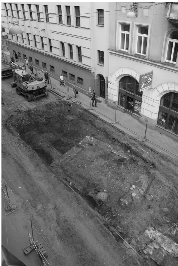
Obr. 30. Jakubská, Rašínova (A086/2007). Pohled na zkoumanou plochu N v severní části Rašínovy ulice.
