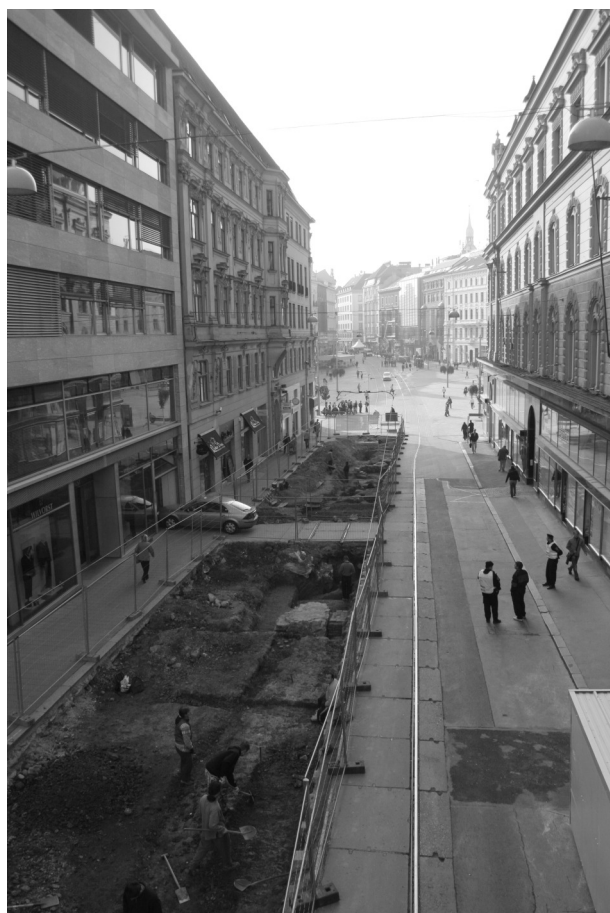
Obr. 33. Jakubská, Rašínova (A086/2007). Pohled od severu na zkoumané plochy B, M na Rašínově ulici.
