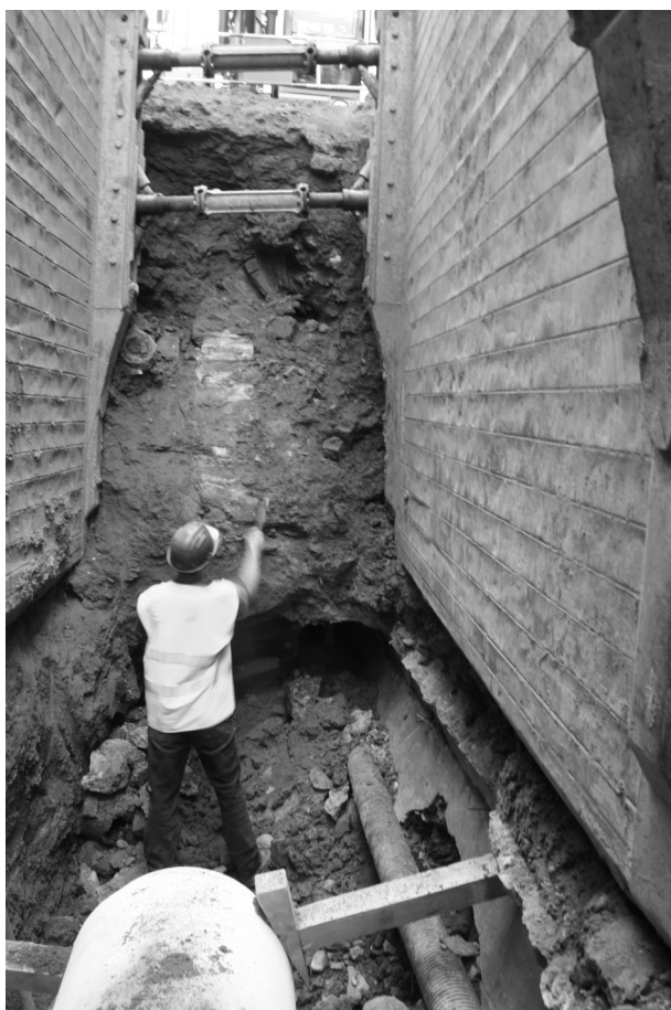
Obr. 17. Běhounská (A020/2009). Začišťování cihlové štolý vodovodu.
