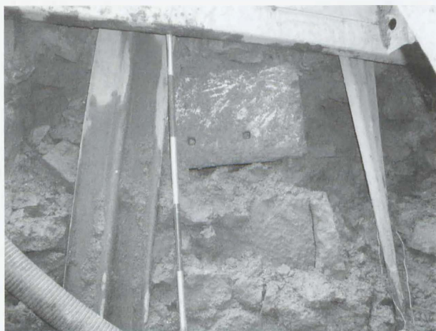
Obr. 115: Uh. Hradiště, U Reduty Str. Druhotně užitě ostění renesančního okna s otvory pro mříže ve vnější hradební zdi (V profil). Abb. 115: Sekundäranwendung der Ummantelung des Renaissancefensters mit den Löchern für ein Gitterwerk in der äußeren Stadtmauer (o. Profil).
