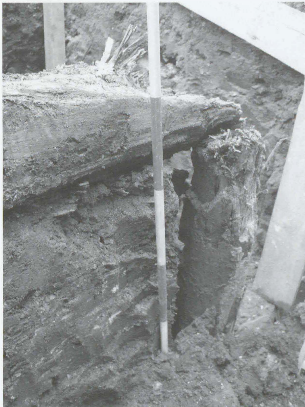
Obr. 112: Uh. Hradiště, Františkánská ulice. Dřevěné konstrukční prvky, sonda „A“. Abb. 112: Františkánská Strasse. Holzkonstruktionsteile, Sonde „A“.
