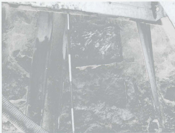
Obr. 115: Uh. Hradiště, U Reduty Str. Druhotně užitě ostění renesančního okna s otvory pro mříže ve vnější hradební zdi (V profil). Abb. 115: Sekundäranwendung der Umarmelung des Renaissancefensters mit den Löchern für ein Gitterwerk in der äußeren Stadtmauer (o. Profil).
