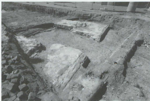
Obr. 19: Česká, Joštova, Žerotínovo náměstí (A064/2007). Části konstrukcí novověké fortifikace. Pohled od jihovýchodu. Abb. 19: Česká, Joštova, Platz Žerotínovo náměstí (A064/2007). Konstruktionsteile der neuzeitlichen Befestigung. Blick von Südosten.
